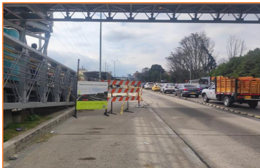
Sentido Norte – Sur
