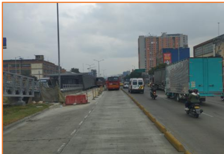
Sentido Sur – Norte
