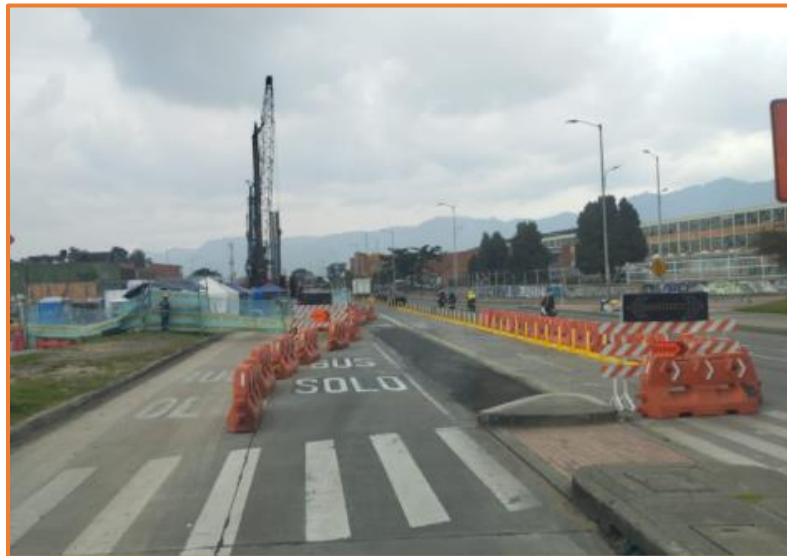
Sentido Sur - Norte
