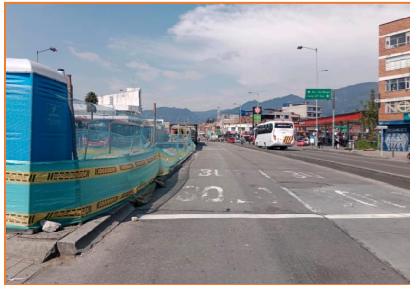
Sentido Sur- Norte
