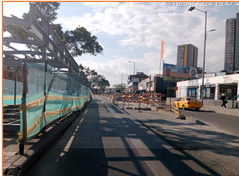
Sentido Sur- Norte
