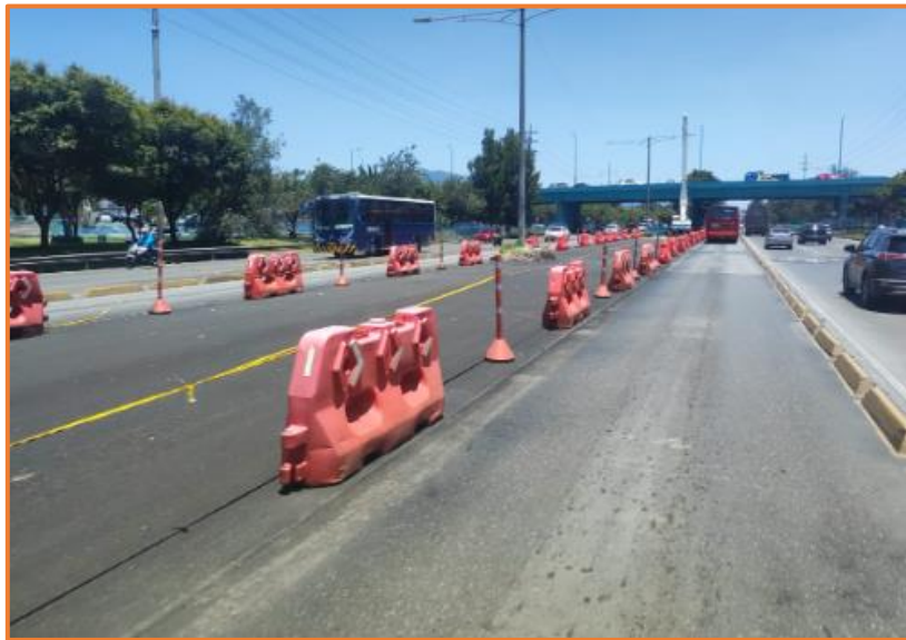
Sentido Sur - Norte
