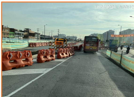
Sentido Sur- Norte
