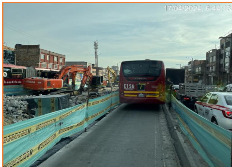
Sentido Sur – Norte
