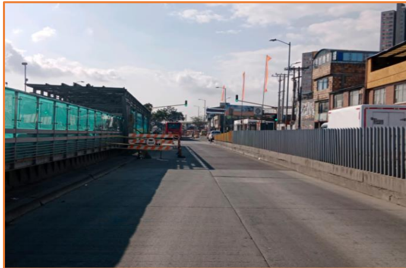
Sentido Sur - Norte
