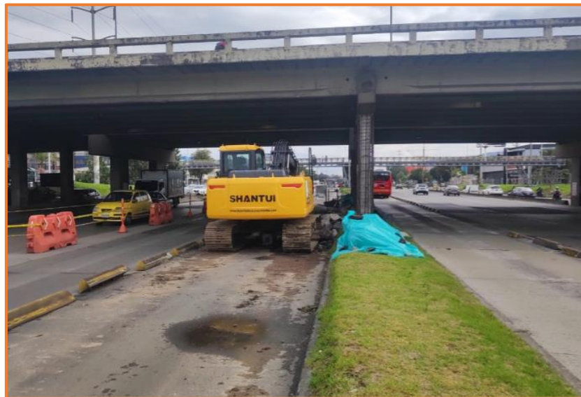
Sentido Sur- Norte
