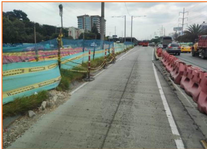
Sentido Sur – Norte
